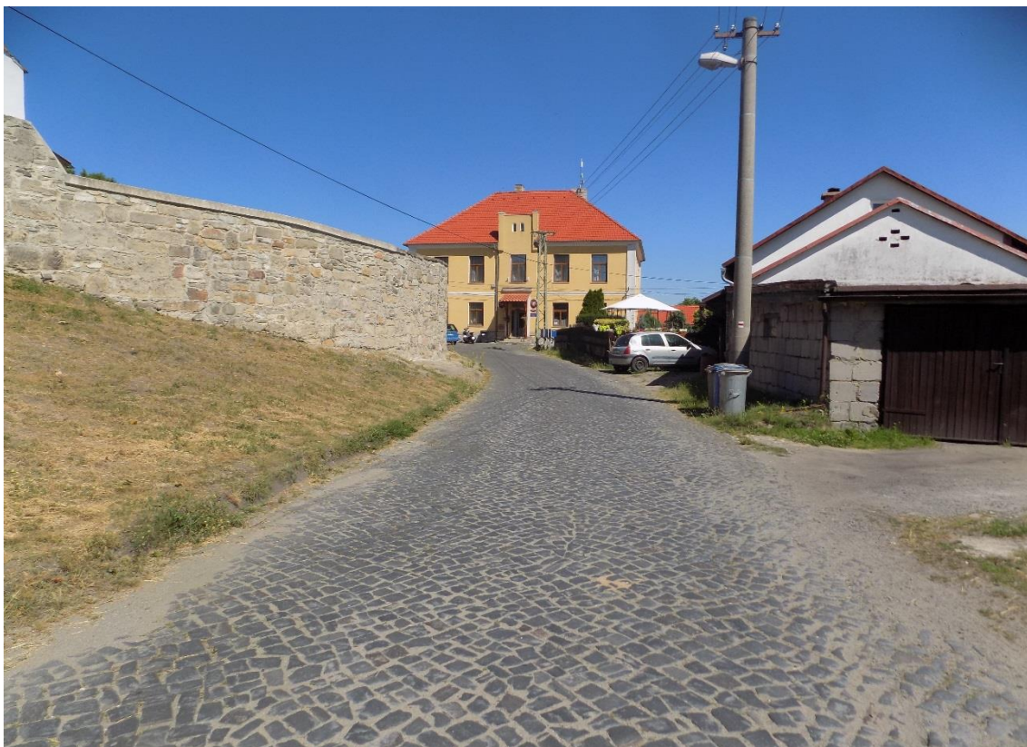
Foto 2: Stávající místní komunikace III. třídy
