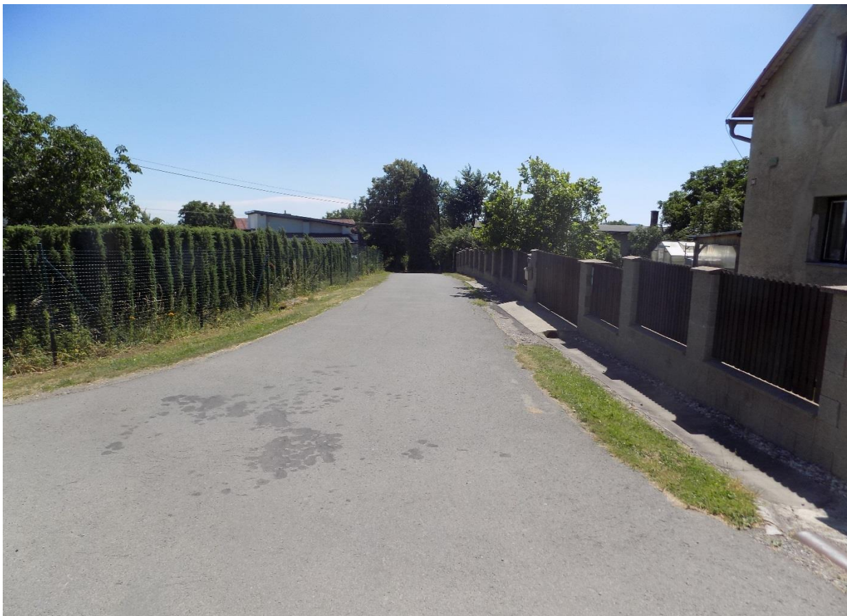
Foto 4: Stávající místní komunikace III. třídy
